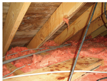
結露により、屋根の断熱材が剥がれ落ちている
