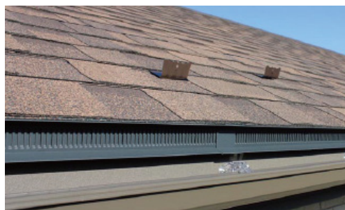
防水性能がある軒先給気部材を使う (TOKO エアーフレッシュ)
