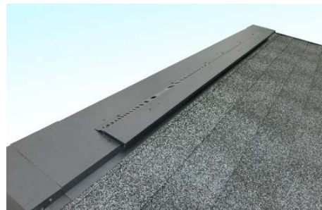
施工された「積雪地域仕様 片流れ双快」
